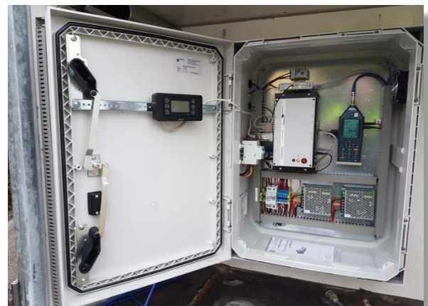
Abb. 4: Messgerät und Modemeinheit:
