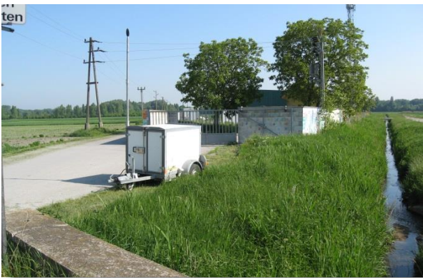
Abb. 3: Foto der Messstelle:
