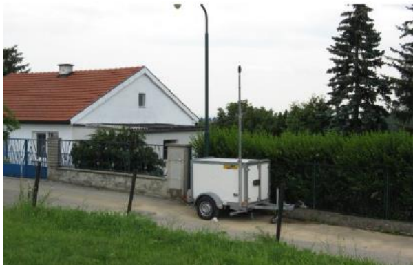
Abb. 3: Foto der Messstelle:
