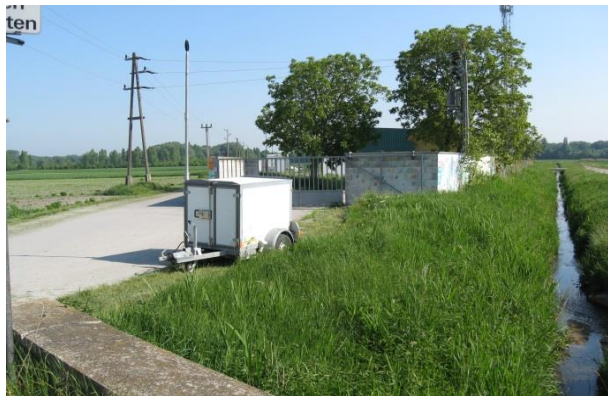
Abb. 3: Foto der Messstelle:
