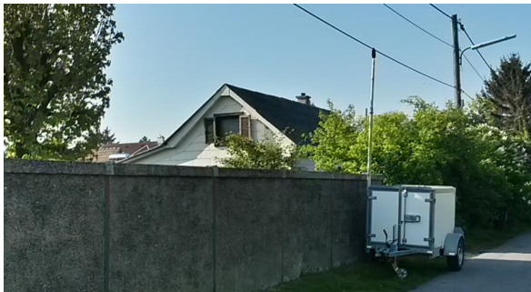
Abb. 3: Foto der Messstelle:
