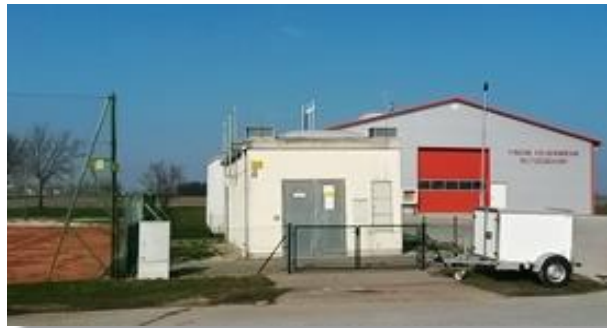
Abb. 3: Foto der Messtelle:
