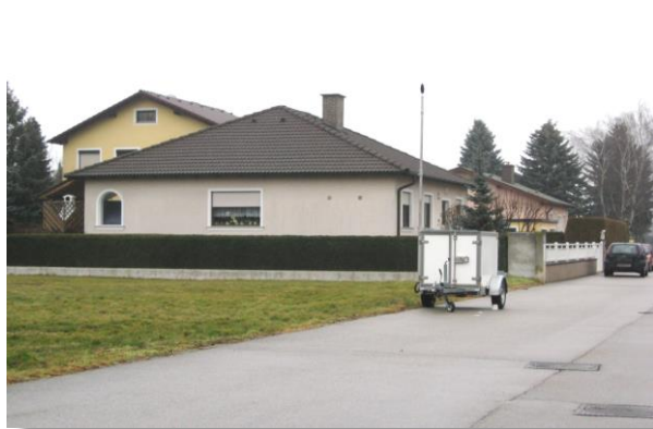
Abb. 3: Foto der Messstelle:
