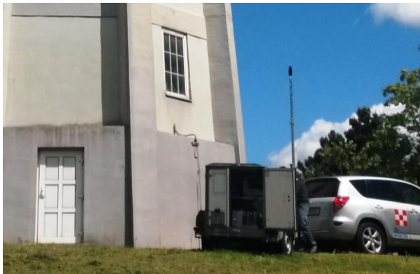
Abb. 3: Foto der Messstelle:
