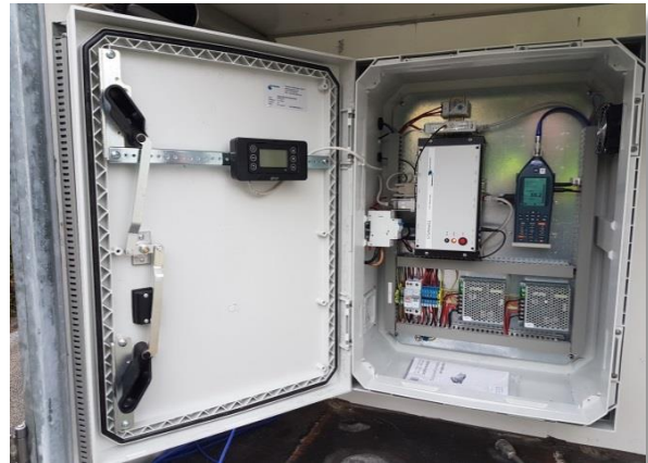
Abb. 4: Messgerät und Modemeinheit:
